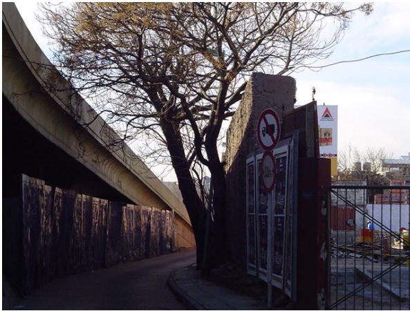
Foto 7: Niceto Vega y Pasaje lateral al viaducto J. B. Justo-Terreno de ubicación de las obras
