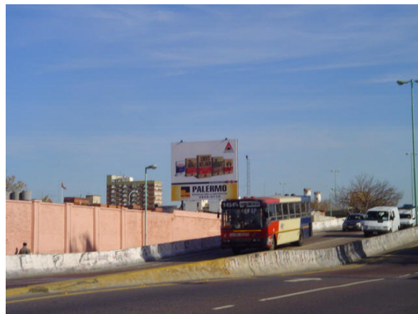
Foto 9: Viaducto Juan B Justo sobre Av Córdoba (desde Cabrera) (Lateral de terreno de las obras)
